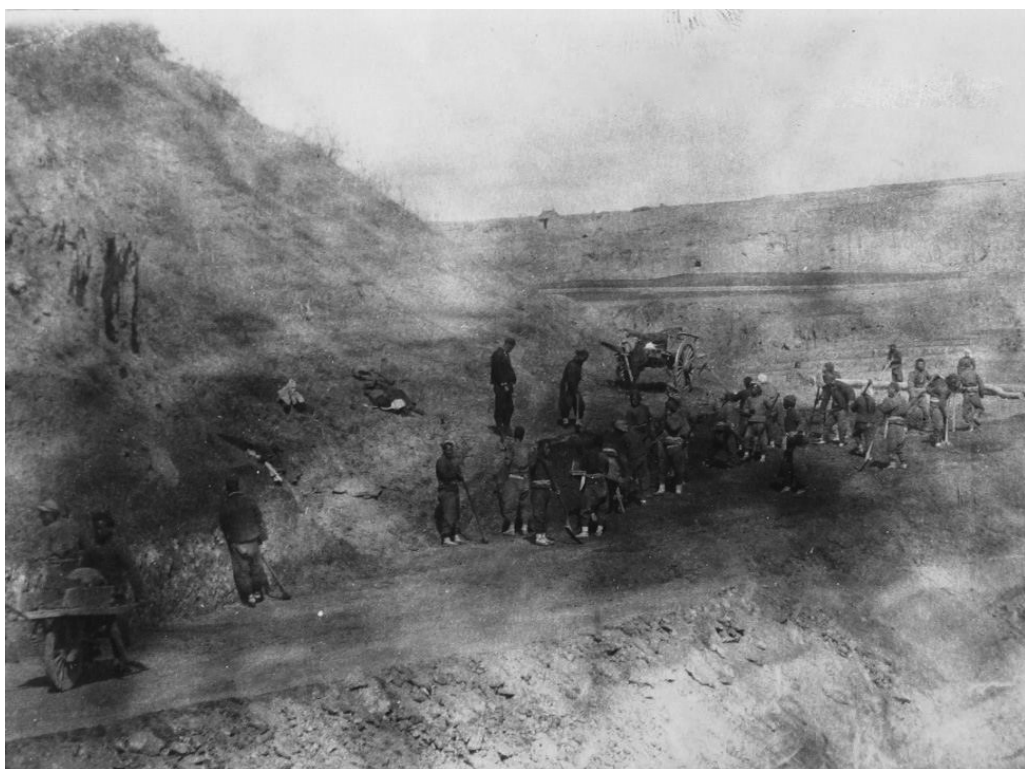
学校筹建初期的筑路工地
