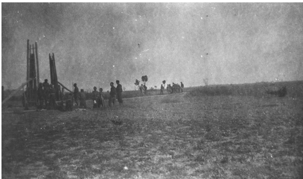
学校筹建初期的基建工地
